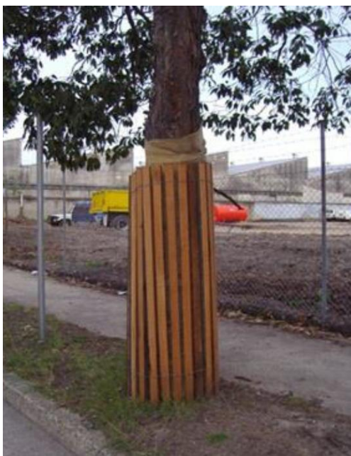
Rysunek 8 Przykład prawidłowego odeskowania drzewa podczas prac budowlanych
